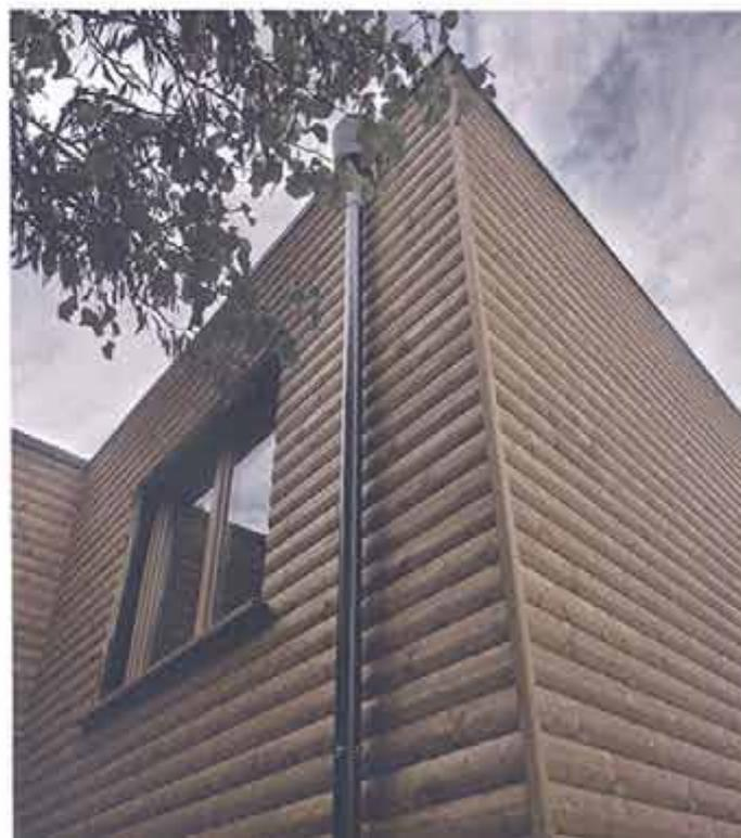
acustico e termico è stato, inoltre, inserito un pannello celenit da 50 mm. Le pareti interne, invece, sono formate da pilastri in legno con una sezione di 80 x 120 mm, abbinati a pannelli di lana di roccia di 100 mm e controventati da entrambi i lati con pannelli OSB di 15 mm. Il tetto piano è composto da travi di legno lamellare di abete, isolato con tre strati di lana di roccia, per un totale di 160 mm.
