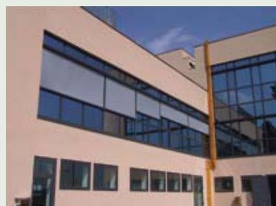
Suncover), consente addirittura un risparmio nell'uso della luce artificiale in situazione diurna: quando cioè con sole basso o con fenomeni di abbagliamento, si è portati ad oscurare completamente il vano finestra, ripiegando sull'illuminazione artificiale.
